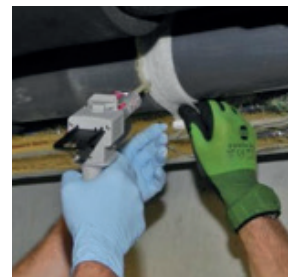
Reparatur PVC-U Klebung d225 mit Tangit RAPID
